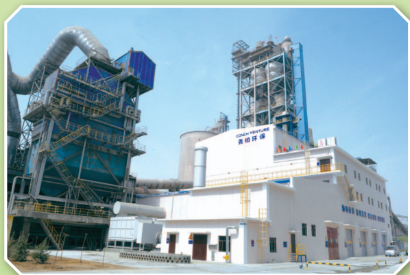
本集團利用水泥窯處置工業固廢的堯柏環保富平項目已投產運行
