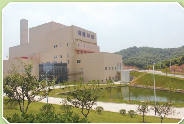
安徽省金寨縣爐排爐垃圾焚燒發電項目全景
