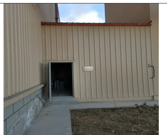
图 4-2 烟气在线监控室
